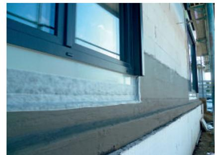
Anschluss eines bodentiefen Fensters im Übergang zur Sockelabdichtung mit PCI Barraseal Turbo und PCI Pecithene Vliesband.
