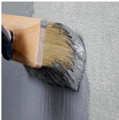
Aufbringen einer Kontaktschicht mittels Bürste oder Quast.
