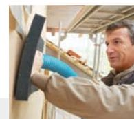
Beim Befüllen mit dem Schlauch oder der Einblasnadel wird ein Abdichtschwamm empfohlen.
