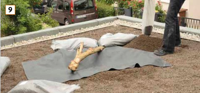
Das Substrat bis auf die Filtervliesebene in der Beckenform entfernen und die mitgelieferte Folie in die vorbereitete Mulde einlegen.
