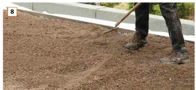
**8** Anschließend mit dem übrigen Substrat Bereiche bis 15 cm Substrathöhe modellieren. Hier können später weitere bienenfreundliche Pflanzen, die mehr Wurzelraum benötigen, ergänzt werden.
