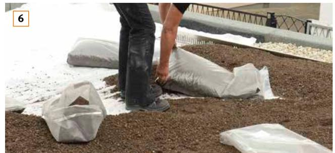
**6** Vegetationssubstrat direkt auf dem Filtervlies verteilen ...
