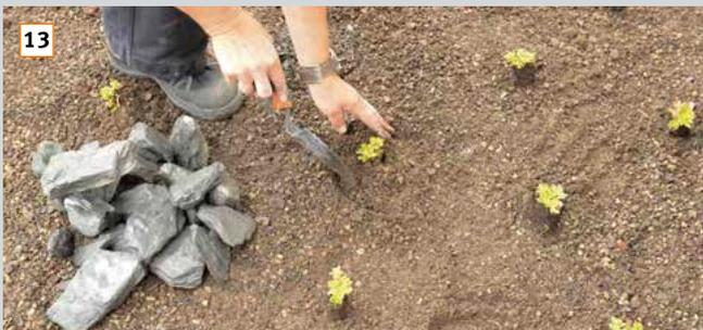
Die Flachballenstauden in den Bereichen mit 5 cm Substrat einsetzen und leicht andrücken, Pflanzabstand ca. 20 – 30 Cm. Die Pflanzballen sollten leicht mit Substrat bedeckt sein. Anschließend die gesamte Fläche durchdringend wässern und den Dünger gleichmäßig verteilen.
