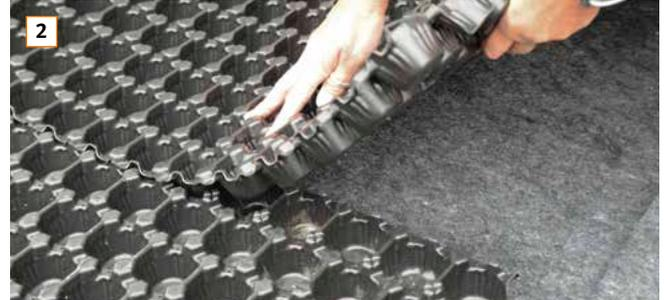
**2** Retentionselement BauderSOLAR RET 40 auf der Schutzlage mit einer Noppenreihe überlappend verlegen.
