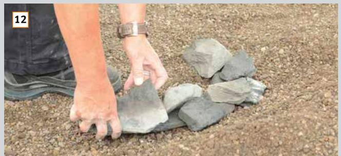
Aus dem mitgelieferten Schieferschotter werden über die Fläche verteilt kleine Steinhaufen aufgeschichtet.
