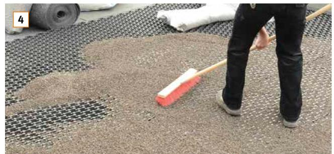
**4** Im Anschluss wird das Retentionselement BauderSOLAR RET 40 vollflächig mit BauderGREEN Mineraldrän BS gefüllt. Empfehlung: mit Besen verteilen und oberflächenplan abziehen.
