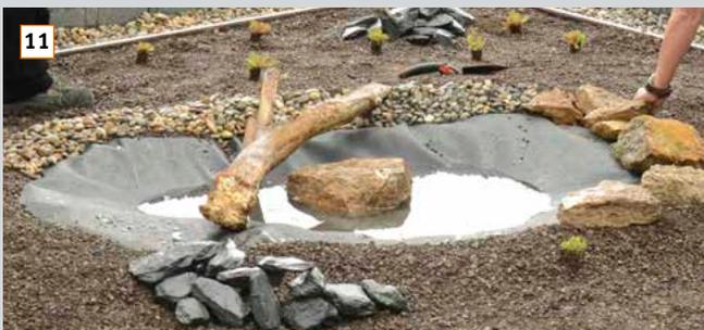
Die Folienränder mit Substrat überdecken. Für eine naturnahe Gestaltung können z.B. Kies, Findlinge, Totholz oder ähnliche Elemente zum Einsatz kommen (nicht im Lieferumfang enthalten). Abschließend das kleine Becken mit Wasser befüllen.
