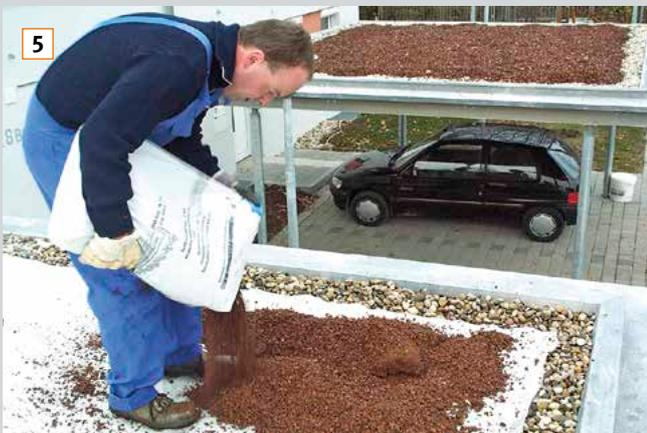
5. Unmittelbar im Anschluss die Pflanzerde aufschütten. Einbaustärke von 5 cm unbedingt genau einhalten. Wasserspeicherplatte und Filtervlies nicht ohne Auflast liegen lassen.
