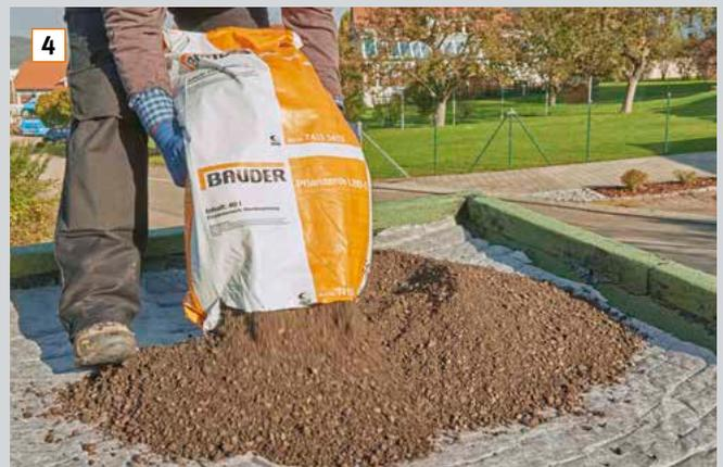
4 Unmittelbar im Anschluss pro Quadratmeter zwei Sack Pflanz Erde einbauen. SDF-Matte nicht ohne Auflast liegen lassen.
