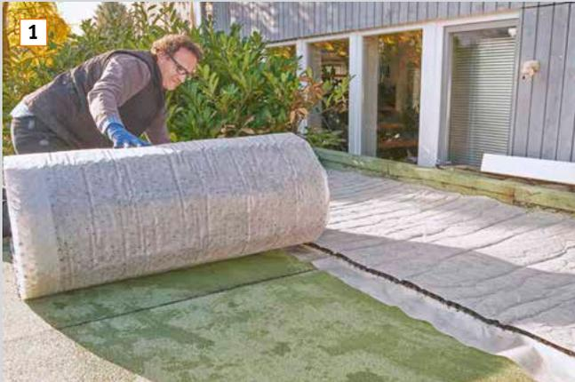
1 Vor der Verlegung Untergrund sauber abkehren und die durchwurzelungsfeste Abdichtung auf Dichtigkeit prüfen. SDF-Matte auf der wurzelfesten Abdichtung ausrollen ...
