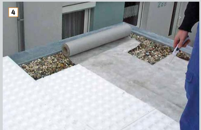
4. Wasserspeicherplatte und Filtervlies im Bereich von Dachabläufen ausschneiden. Kontrollschacht aufstellen oder Kies aufbringen – s. Hinweise in Checkliste.
