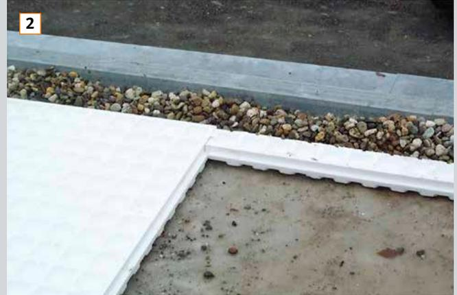
2. ... Wasserspeicherplatte bis zum Rand verlegen. Die Wasserspeicherplatte lässt sich mit einem Teppichmesser schneiden. 2. Reihe mit dem Abschnitt der ersten Reihe beginnen.
