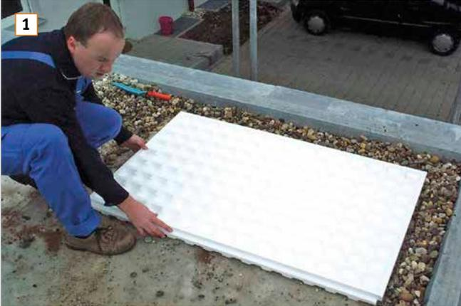
1. Untergrund abkehren und die Abdichtung auf Dichtigkeit prüfen. Wasserspeicherplatte auslegen. Bei niedrigem Dachrand kann Kies zum Höhenausgleich verwendet werden, sonst ...
