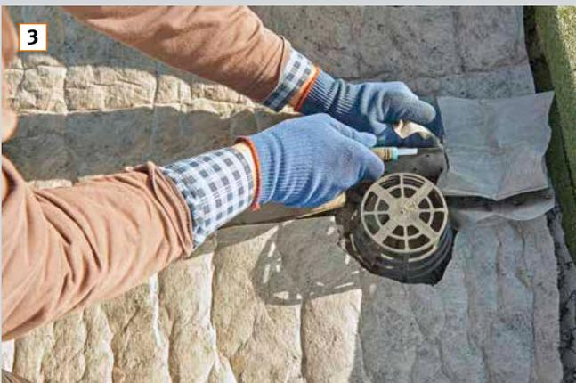
3 Im Bereich von Dachabläufen SDF-Matte ausschneiden. Kann kein Kontrollschacht aufgestellt werden, Dachablauf mit Grobkies einfassen – vgl. Checkliste.
