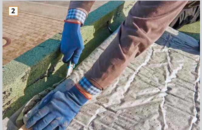
2 ... zurechtschneiden und vollflächig, stumpf gestoßen verlegen. Überlappung der Längsnähte schließen.
