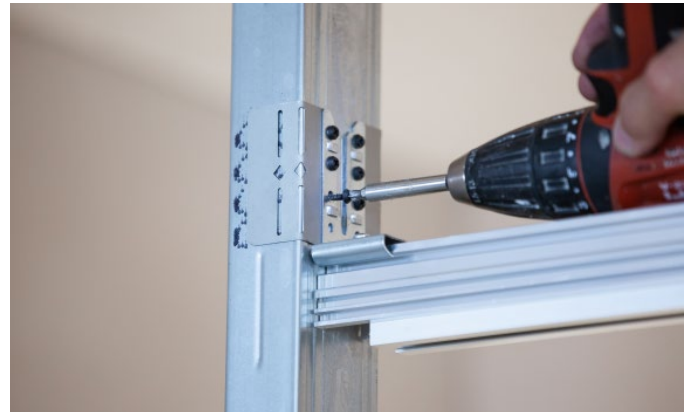
Bild 43: Sicherungslaschen entfernen
