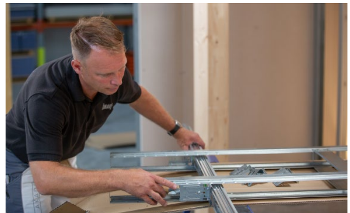
Bild 21: Tragschiene montieren
