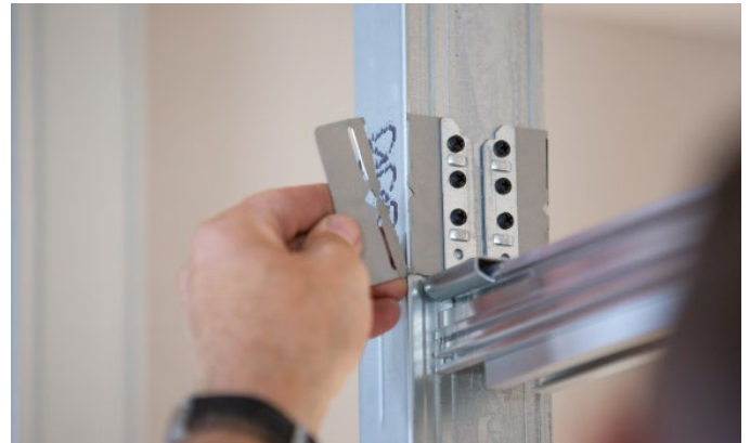
Bild 44: Befestigung der Verbindungsplatten
