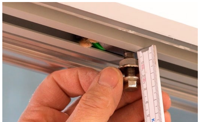
Bild 57: Türblatt einsetzen
