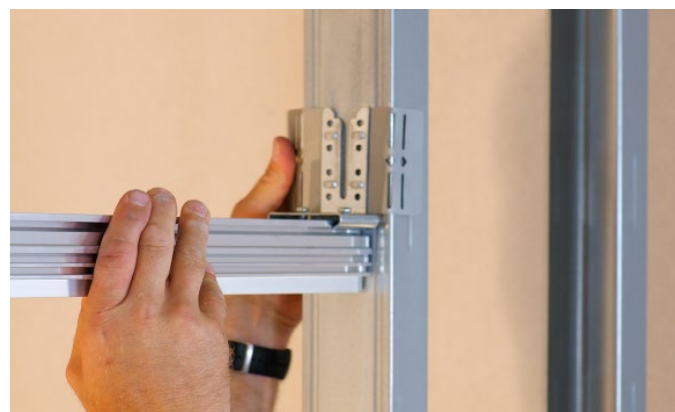
Bild 28: Sicherungslaschen umklappen
