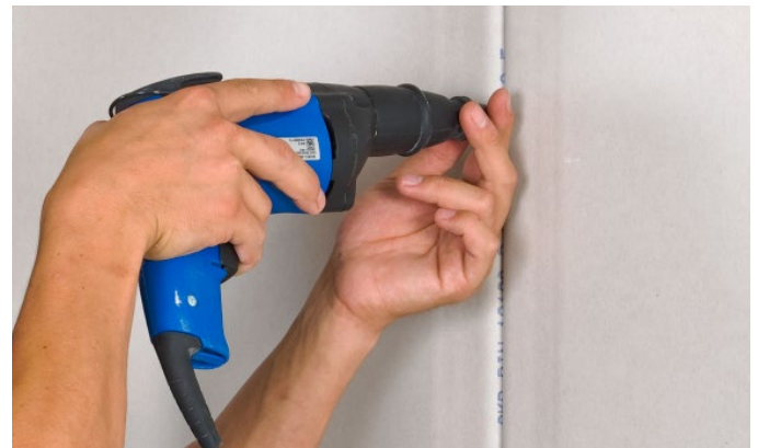
Bild 54: Entfernen der Montagehilfen
