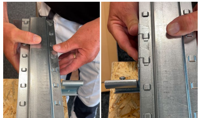
Bild 13: Distanzstücke einstellen
