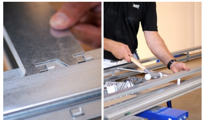
Bild 12: Distanzstück montieren
