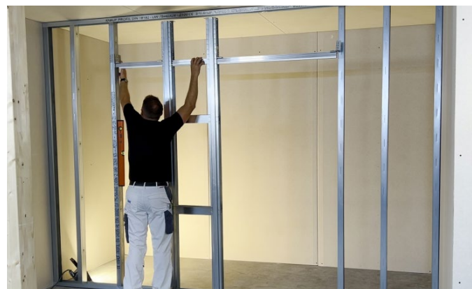
Bild 28: Sicherungslaschen umklappen
