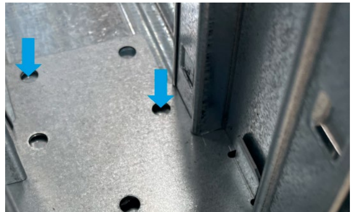
Bild 44: Befestigung der Verbindungsplatten
