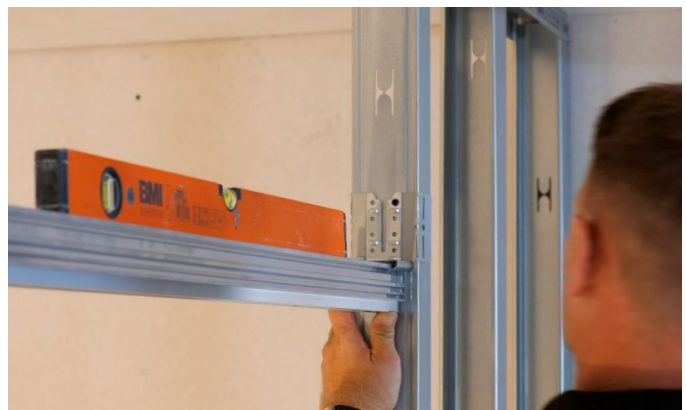
Bild 40: Ausrichtung Tragschiene
