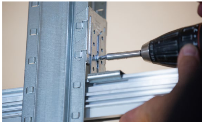
Bild 40: Ausrichtung Tragschiene
