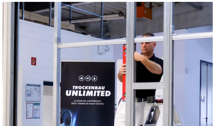
Bild 31: Meterriss im Taschenprofil prüfen
