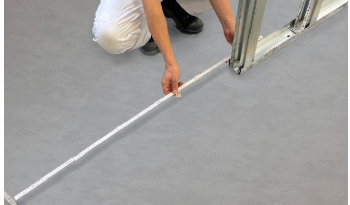
Bild 30: Ständerprofile ausrichten
