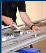
1 Ständerprofile mit den Traversen **einfach vormontieren** und am Stück in die Wandkonstruktion einstellen
