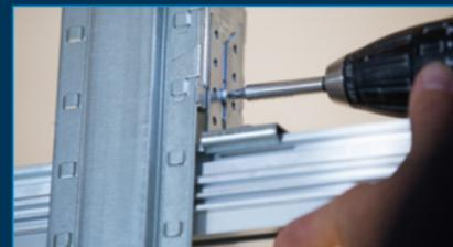
6 Schrauben ermöglichen **exaktes Justieren** der Höhe vor dem Festschrauben
