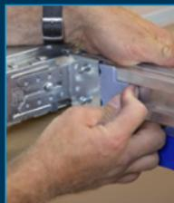
4 Ein Montageclip sichert die Position für das Anschrauben der Tragschiene
