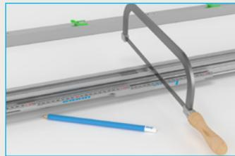
**2** Tragschiene und Laufschiene können bei schmaler Wandöffnung leicht **auf das nötige Maß gekürzt** werden
