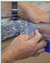
**4** Ein Montageclip sichert die Position für das Anschrauben der Tragschiene
