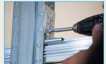
**6** Schrauben ermöglichen **exaktes Justieren** der Höhe vor dem Festschrauben
