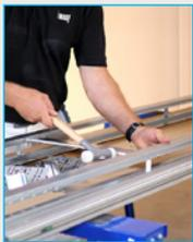
**1** Ständerprofile mit den Traversen **einfach vormontieren** und am Stück in die Wandkonstruktion einstellen
