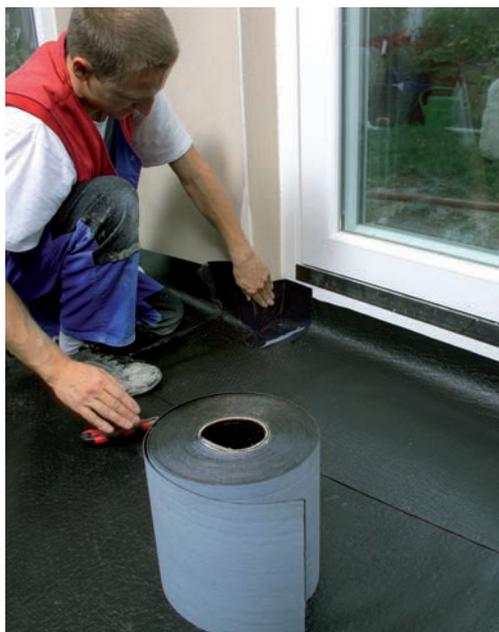
MOGAFIX KSK-E 40 ist die neue Elastomerbahn für Feuchtigkeitsabdichtungen unter Estrich-Konstruktionen.
