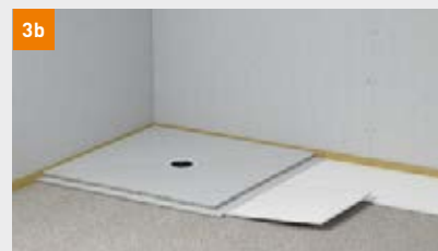
Variante B: Um auf die Höhe des Stufenfalzes vom Duschelement zu kommen, wird über die Fläche 10 mm dicker Dämmstoff (EPS DEO 150) verlegt
