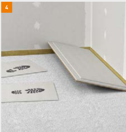
Verlegen der fermacell Estrich-Elemente auf fermacell Ausgleichsschüttung
