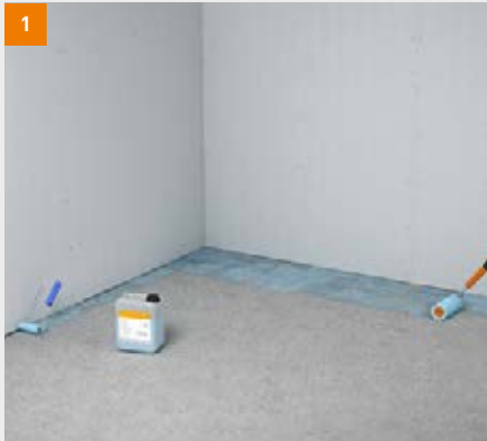
1 Grundierung des Untergrundes mit fermacell Tiefengrund
