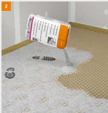
2 fermacell Wabenschüttung einbringen
