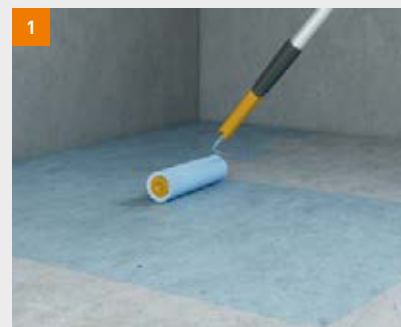
Vorbereitung: Boden grundieren
