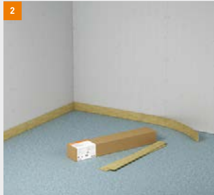
2 Anschließend erfolgt bei Bedarf das Anbringen des Randdämmstreifens
