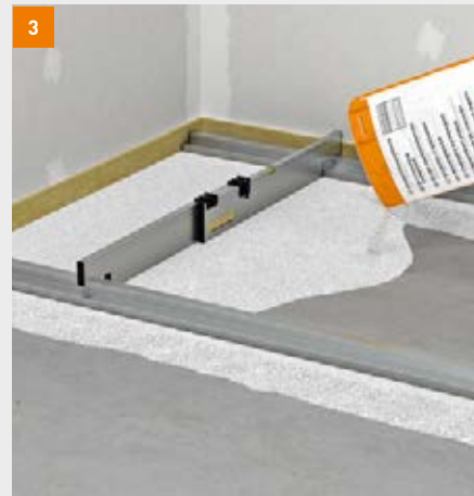
fermacell Ausgleichsschüttung einbringen
