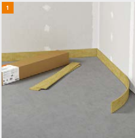
Anbringen der Randdämmstreifen
