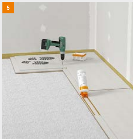
Verlegen der fermacell Estrich-Elemente auf fermacell Ausgleichsschüttung
