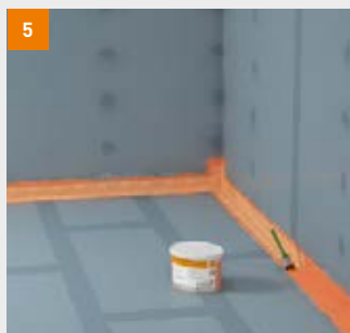
5 Dichtband direkt nach dem Eindrücken mit fermacell Flüssigfolie überstreichen
