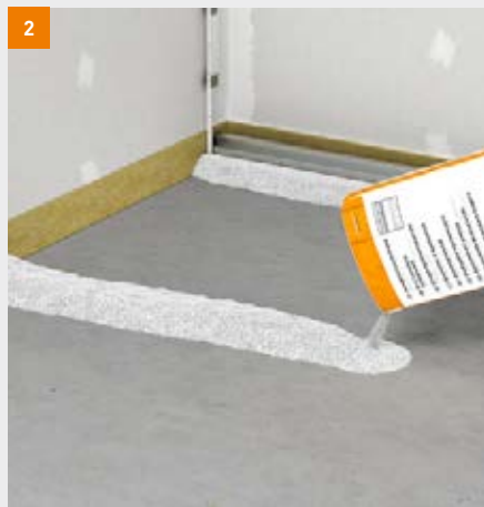
Anlegen der Dämme
