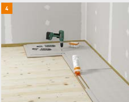
4 Auftragen des fermacell Estrich-Klebers im Falzbereich
