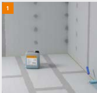
1 fermacell Tiefengrund im angrenzenden Wandbereich ...
