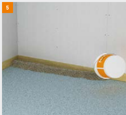
5 Anschließend hat die gebundene Schüttung eine erdfeuchte Konsistenz. Der erste Damm wird angelegt
