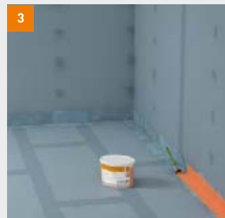
3 fermacell Flüssigfolie in der Ecke auftragen
