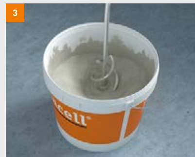
Mit geeignetem Rührgerät bei langsamer Drehzahl anmischen, bis eine homogene, klumpenfreie Nivelliermasse entsteht
