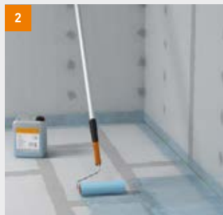
2 ... und Bodenbereich per Rolle auftragen
