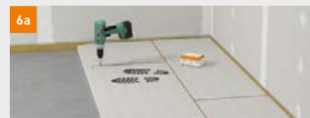
3 Verlegen der fermacell Estrich-Elemente
