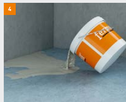
Boden-Nivelliermasse ausbringen und planeben nivellieren
