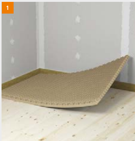
1 fermacell Estrich-Wabe verlegen
