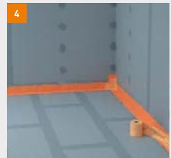
4 In die feuchte Flüssigfolie das fermacell Dichtband eindrücken
