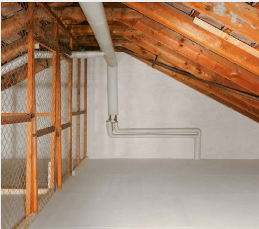
Nut- und Federverbindung: schnelle Verlegung ohne Wärmebrücken
