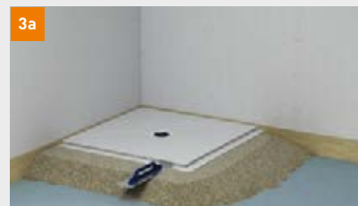
Variante A: Um das Duschelement wird in Höhe des überstehenden Falzes ein ca. 200 mm breiter Damm geschüttet – als Auflage für das Abziehen der restlichen Fläche
