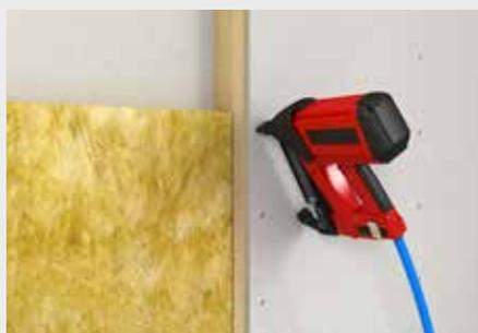
Klammern auf Holzunterkonstruktion
