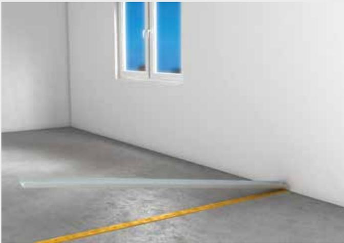
Auslegen der UW-Anschlussprofile am Boden auf Dämmstreifen
