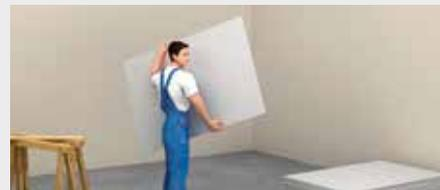
Einzelne **fermacell** Gipsfaser-Platten hochkant tragen
