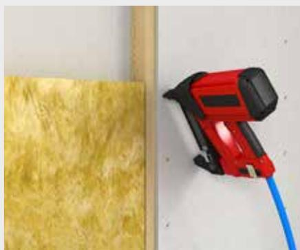
Beplankung der Holzunterkonstruktion mit Klammern
