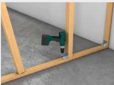
Montage der Holzständer mit Stiftnagel oder Stahlwinkel
