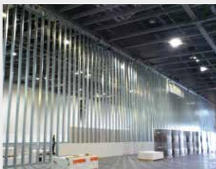
Trotz großer Einbauhöhen von fast 10 m und geringer Konstruktionsdicke werden die fermacell Wände den hohen statischen Anforderungen gerecht
