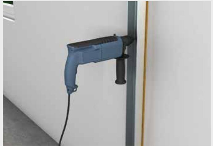
Befestigung der CW-Profile an Massivwand auf Dämmstreifen
