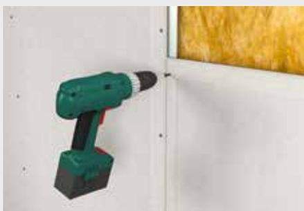
Schrauben auf Stahlunterkonstruktion
