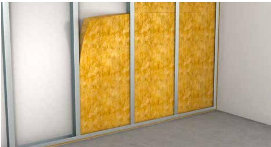
Einbringen der Dämmstoff-Platten
