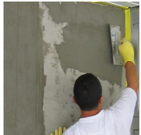
PCI Barrafill L für Kosmetikarbeiten an Betonbauteilen.
