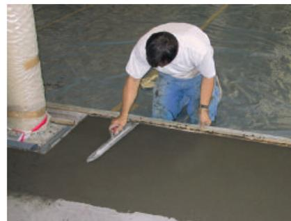
PCI Novoment M1 plus ist ein Schnellestrich-Fertigmörtel und daher eine wirtschaftliche und besonders praktische Lösung für den Einbau von kleineren Flächen und Estrich-Teilflächen, die schnell genutzt werden müssen.
