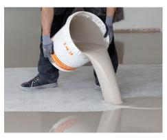
Der extrem leichte Verlauf von PCI Periplan® Flow, ermöglicht einen sehr schnellen und kostengünstigen Baufortschritt.
