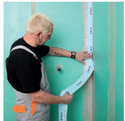
Anschließend wird das Spezial-Dichtband PCI Pecitape 120 mit der Hand ausgerichtet und leicht angedrückt...
