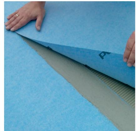
Mit der PCI Pecilastic W können feuchtigkeitsempfindliche Untergründe schnell und sicher abgedichtet werden.
