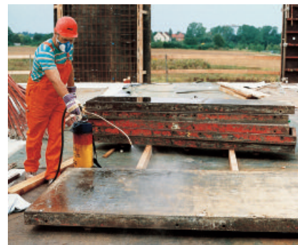
Mit PCI Schalöl werden Holz-, Stahl- und Kunststoffschalungen behandelt.
