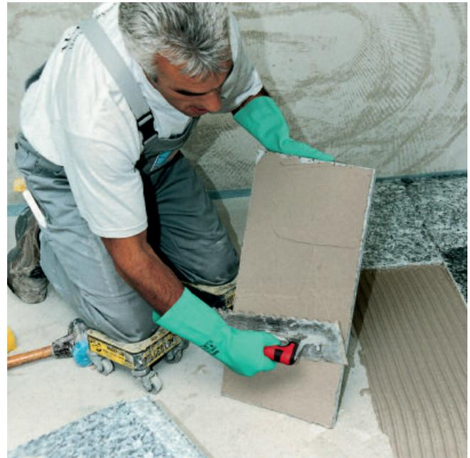
Zum hohlraumfreien Verlegen wird grundsätzlich eine Mörtelschicht auf die Plattenrückseite aufgetragen.
