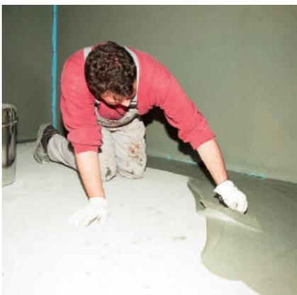
4. ... oder der zementären Sicherheits-Dichtschlämme PCI Seccoral
