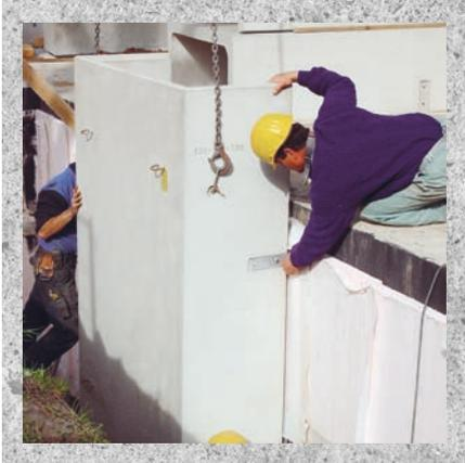
Die EnEV schreibt vor, dass Wärmebrücken mit Maßnahmen nach dem „Stand der Technik“ vermieden werden müssen. Durch die Montage mit Winkel-laschen stehen für Betonfertigteilschächte SAS geeignete Befestigungen zur Verfügung. Betonfertigteilschächte SAS können direkt auf der Dämmschicht montiert werden. Dadurch bilden sich keine Wärme-
