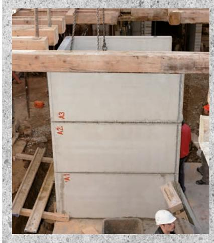
Der Vorteil bei Aufzugsschächten von JÄGER bei Sanierungen ist der geringe Platzbedarf. So kann auf engstem Raum der Schacht versetzt werden.
