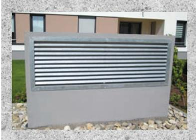
Die neuen modernen Wohnanlagen mit Tiefgaragen setzen oftmals eine Entlüftung voraus. Wir haben eine geeignete Lösung der Tiefgaragenentlüftung über Öffnung in der Decke gefunden.
