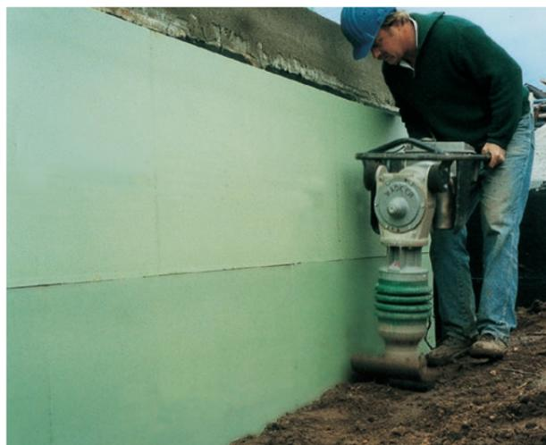
Abb. 28: Lagenweise Verfüllung der Baugrube und mechanische Verdichtung.
