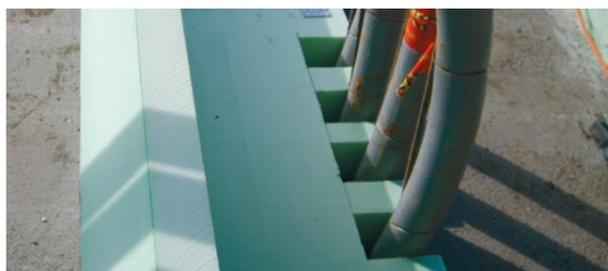
Aussparungen oder Durchdringungen werden nach den baulichen Anforderungen und örtlichen Gegebenheiten ausgeschnitten. Spezial-PU-Schaum dichtet verbleibende Hohlräume ab.
