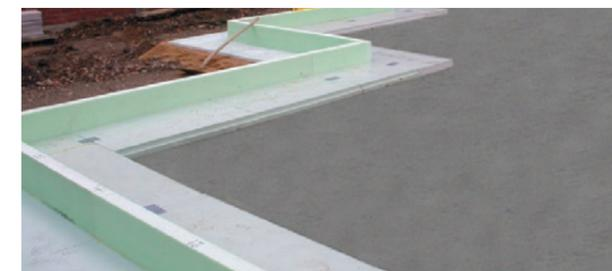
Um in Teilbereichen eine kostenintensive Gründung bis zur Frosttiefe zu vermeiden, ist ein Frostschirm nach EN ISO 13793 erforderlich. Dieser wird werkseitig an das Randelement angebracht und als waagrechte Erdreichdämmung eingesetzt.
