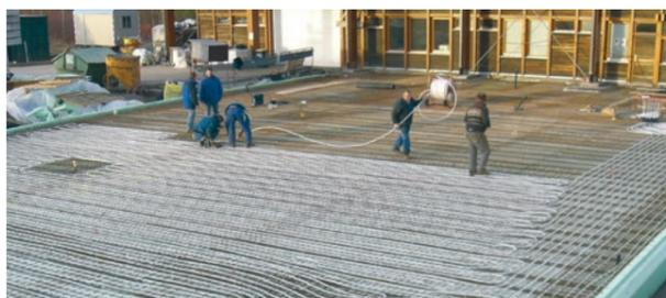
Die thermisch aktivierte Bodenplatte dient als großflächiger Wärmespeicher und führt zu Energieeinsparungen von bis zu 30 Prozent. Die Reduzierung des Fußbodenaufbaus sorgt zusätzlich für einen Raumhöhengewinn.
