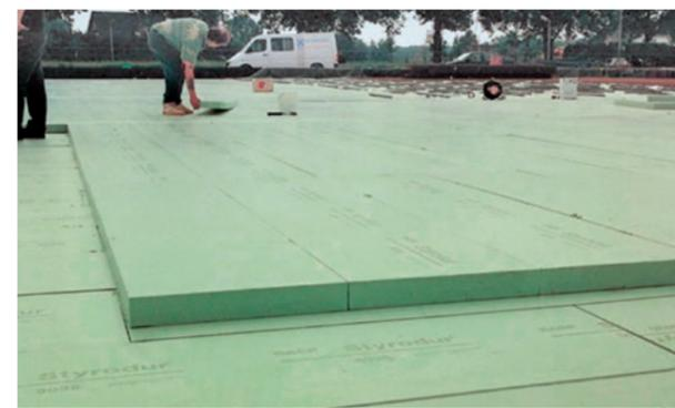
Abb. 8: Mehrlagige Verlegung von Styrodur®-Platten unter Bodenplatte.
