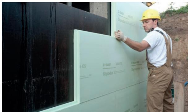
Abb. 4: Dichtgestoßene Styrodur®-Platten sorgen für eine wärmebrückenfreie Perimeterdämmung.
