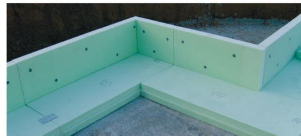
Im Bausatz passgenau vorgefertigte und nummerierte Eckelemente gewährleisten auch bei gegliederten Gebäudegrundrissen ein millimetergenaues Verlegen der Randelemente. Dadurch entfällt das zeitaufwendige Einmessen und Einschalen der Bodenplatte.
