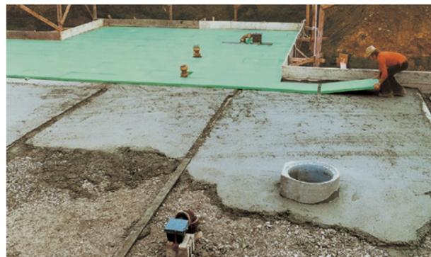
Abb. 6: Sauberkeitsschicht aus Magerbeton zur Verlegung der Bodendämmung.
