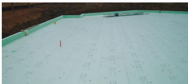
Für eine exakte und wärmebrückenfreie Bodenplatte sind zwei wesentliche Faktoren maßgebend: die bauaufsichtlich zugelassene, dreilagige Dämmschicht aus Styrodur® sowie eine professionelle Arbeitsvorbereitung mit verständlichen Montage- und Verlegeplänen.
