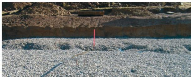
Ein Splittbett als Sauberkeitsschicht und Nivellierebene sorgt für einen ebenen Unterbau. Diese Tragschicht wird gemäß den Anforderungen an den Baugrund und den Angaben des Statikers aufgeschüttet und verdichtet.
