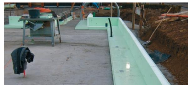
Die Anordnung und Verlegung der geradlinigen Randelemente erfolgt nach einem je nach Objekt gefertigten Verlegeplan auf dem ebenen Unterbau.
