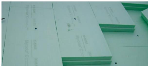
Mit Dämmstoffankernägeln wird die Haftsicherung der einzelnen Dämmlagen untereinander sichergestellt. Somit ergibt sich ein fugenfreier und stabiler Unterbau.
