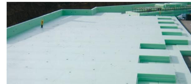
Die zweite Dämmlage, ebenfalls aus Styrodur®-Platten mit allseitigem Stufenfalz, wird fugenversetzt zur ersten Plattenlage eingebaut – ebenfalls im schleppenden Verband.
