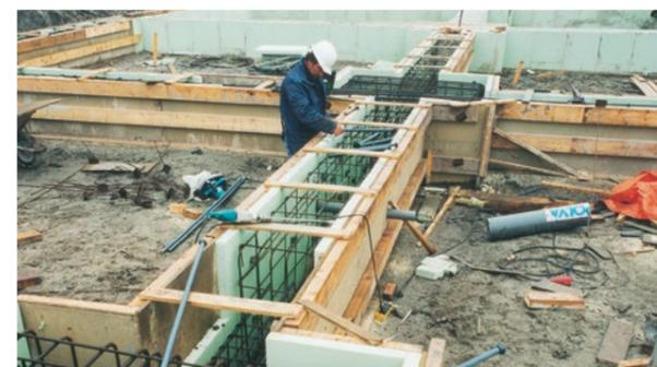
Abb. 25: Schalung mit Styrodur®.
