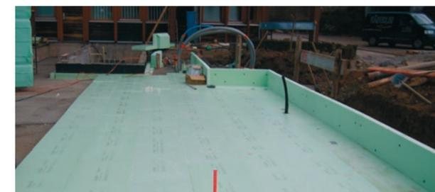
Die Styrodur®-Platten mit allseitigem Stufenfalz werden in der ersten Dämmlage im schleppenden Verband nach EN 12606 verlegt. Der Verlegebeginn und die Verlegerichtung erfolgt objektbezogen und individuell nach gefertigten Montageplänen.
