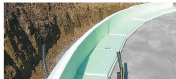
Die werkseitig gefertigten, runden Randelemente werden nach den erforderlichen Radien ausgerichtet und verlegt. Somit lassen sich auch runde Bodenplattengrundrisse exakt und genau herstellen.
