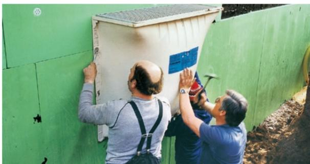
Abb. 22: Lichtschachtmontage bei Perimeterdämmung
