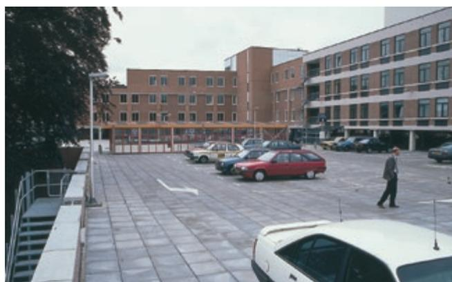
Abb. 43: Parkdach mit Betonplatten auf UK-Dach mit Styrodur®.
