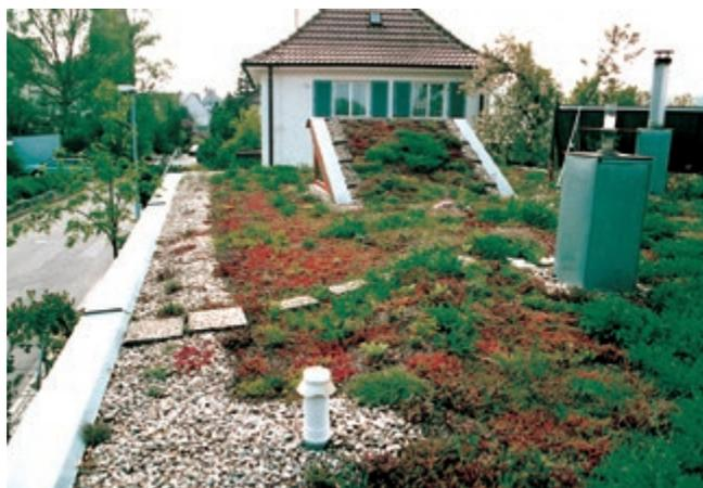
**Abb. 35:** Kiesstreifen am Dachrand und an Dachdurchdringungen.
