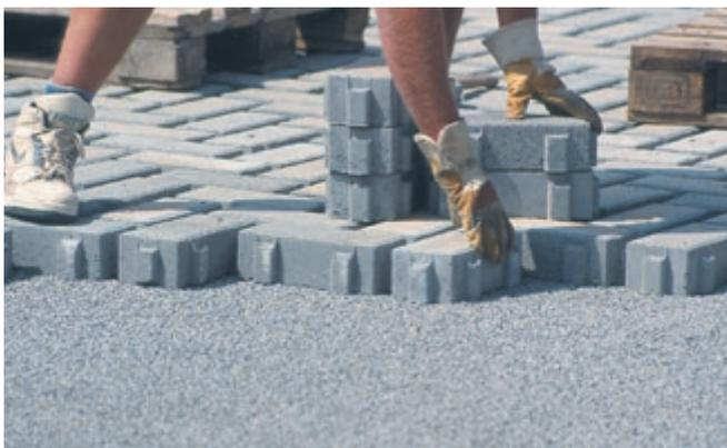
Abb. 45: Verbandverlegung eines Betonpflasters mit Grasfugen für einen Parkplatz auf einer Schulsporthalle.
