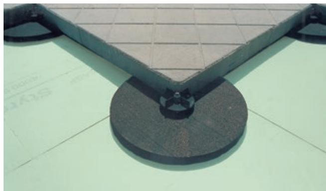
Abb. 42: Auf Styrodur® verlegte Betonplatten unter Verwendung von Aufegersystem.
