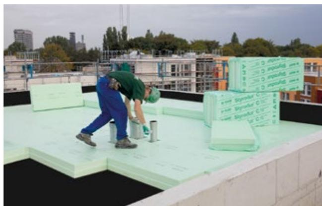
**Abb. 3:** UK-Dach-Dämmung mit Styrodur® von 250 Wohneinheiten in Hamburg.
