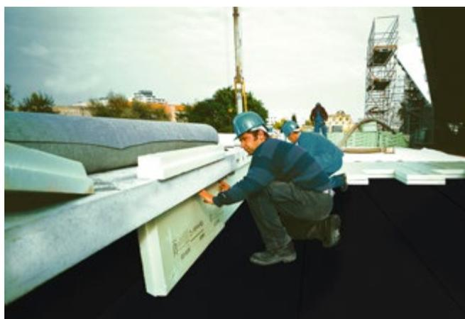
Abb. 14: Attika-Dämmung mit Styrodur®.
