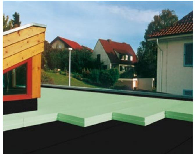
**Abb. 25:** Verlegung von Styrodur®-Platten unter extensiver Dachbegrünung.
