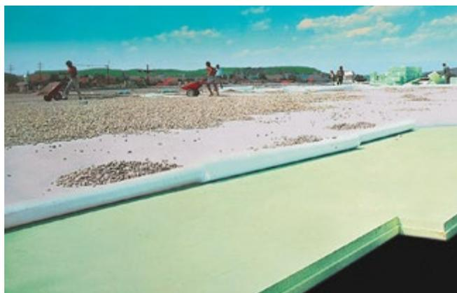
**Abb. 9:** UK-Dach mit Trennlage und Kiesschüttung.
