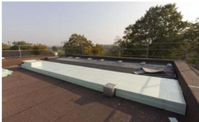
**Abb. 1:** Styrodur® ist aufgrund seiner Druckfestigkeit, geringen Wasseraufnahme und geringen Wärmeleitfähigkeit für UK-Dachkonstruktionen hervorragend geeignet, z. B. bei Flachdachsanierungen als Plus-Dach.
