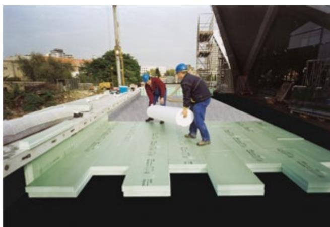
Abb. 15: Verlegung von Styrodur® oberhalb der Dachabdichtung.
