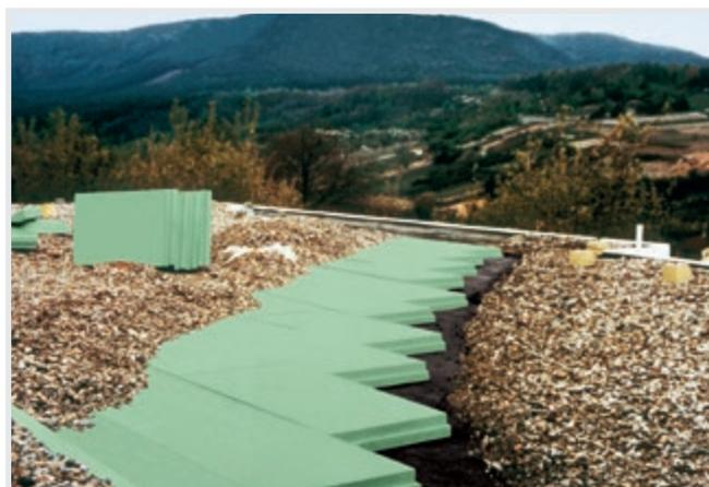
**Abb. 18:** Saniertes UK-Dach als Plusdachkonstruktion.
