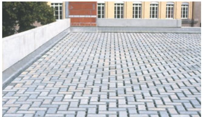
Abb. 47: Verlegtes Betonpflaster auf Styrodur®.
