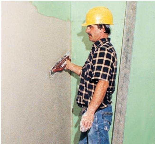
Abb. 32: Aufziehen der ersten Lage des Gips-Haftputzes; Auftragsdicke 10 mm.
