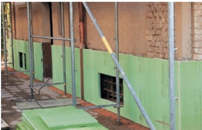
**Abb. 17:** Nachträgliche Sockeldämmung mit Styrodur® 2800 C.
