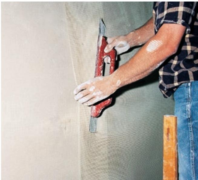
Abb. 33: Ganzflächiges Einlegen des Glasfaser-Gitter-Armierungsgewebes. Die Gewebestreifen werden etwa 100 mm überlappt.
