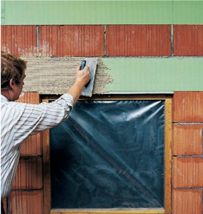
**Abb. 20:** Fenstersturz in wärmedämmendem Mauerwerk; horizontales Aufkämmen der Putzhaftbrücke.
