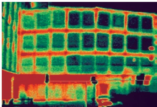
**Abb. 6:** Thermogramm eines Bürogebäudes.
