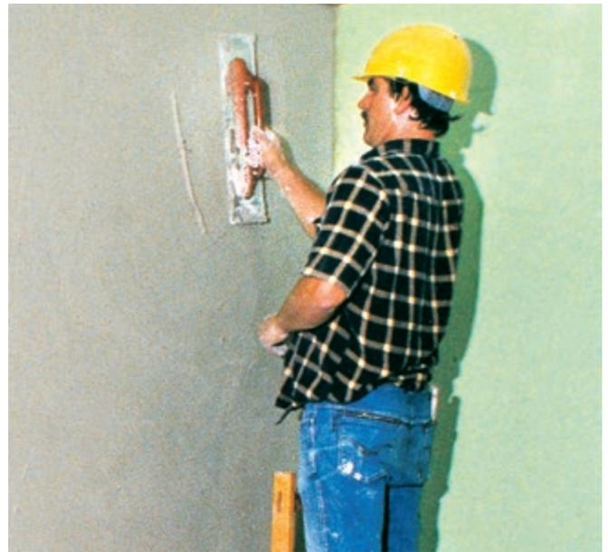
Abb. 34: Aufziehen der zweiten Lage des Putzes, Schichtdicke etwa 5 mm. Der Putzauftrag erfolgt nass in nass.
