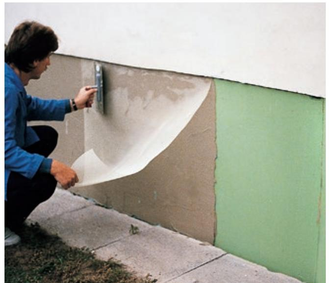
**Abb. 29:** Einlegen des Glasgitterfaser-Gewebes in den Grundputz der Sockeldämmung.
