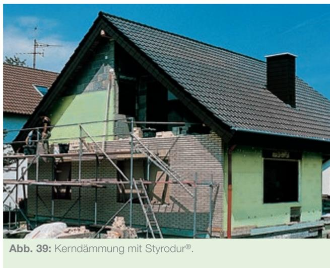
**Abb. 39:** Kerndämmung mit Styrodur®.
