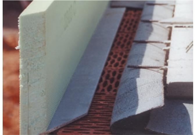
Abb. 8: Deckenrandschalung mit Styrodur® 2800 C.
