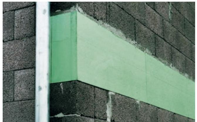
**Abb. 2:** Wärmedämmung am Deckenrand mit Styrodur® 2800 C.
