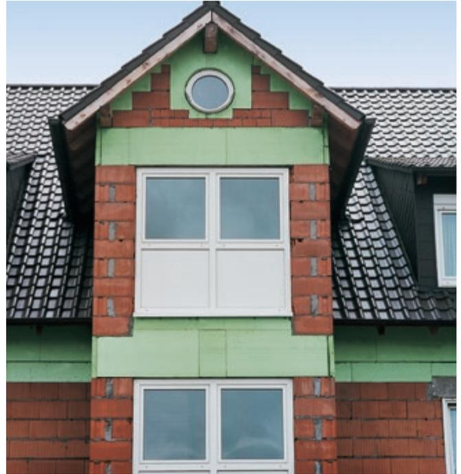
**Abb. 1:** Wärmebrückendämmung von Betonbauteilen:
