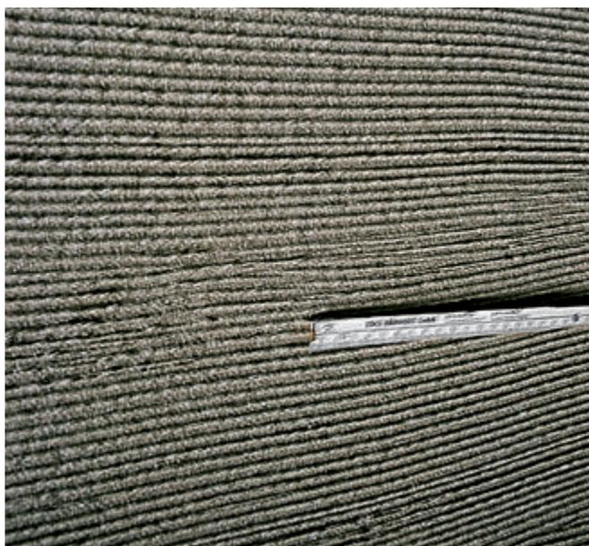
**Abb. 24:** Horizontal gekämmte Haftbrücke auf Styrodur®-Dämmung.
