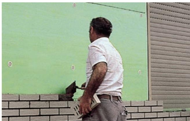
**Abb. 38:** Kerndämmung mit 9 cm breiten Vormauerziegeln.
