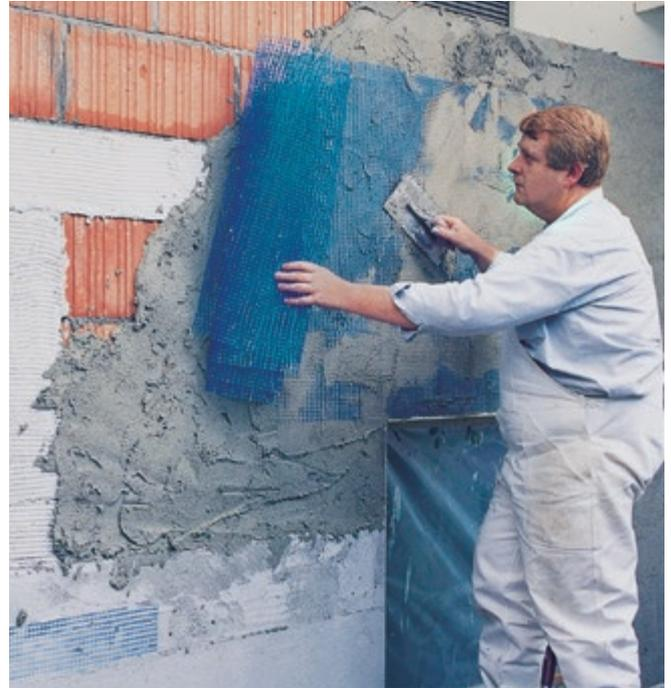
**Abb. 22:** Aufbringen des Grundputzes und Einlegen der Glasfaser-Gitterarmierung über den gedämmten Betonbauteilen.
