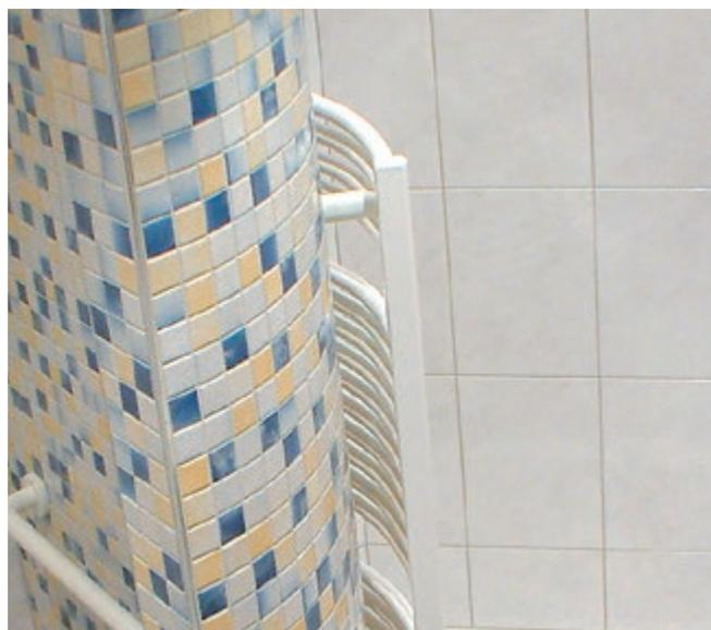
Abb. 41: Anwendungsbeispiel für Fliesenelemente aus Styrodur®: Bad.
