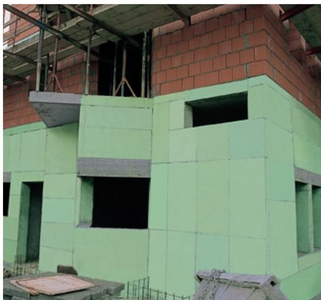
**Abb. 25:** Großflächige Dämmung eines Erdgeschosses mit Styrodur®-Platten.
