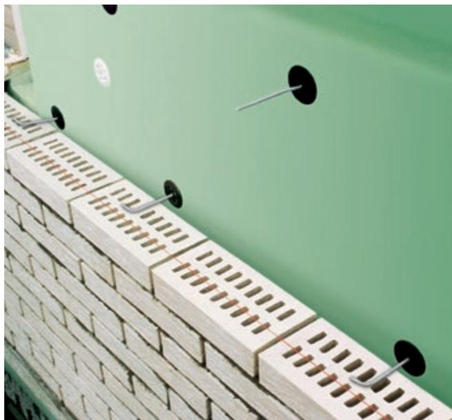
**Abb. 40:** Vormauerschale aus Kalksandsteinen, Befestigung mit Bohrankern.
