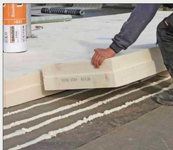
Bei objektspezifischen Besonderheiten kann sich die notwendige Klebermenge erhöhen. Zur Verklebung darf ausschließlich der Bauder Schaumkleber verwendet werden. Bei geplanter Verwendung von anderen Klebern und bei objektspezifischen Besonderheiten informieren Sie sich bitte bei der Bauder Anwendungstechnik.
