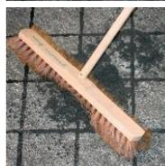
5. Mörtelreste mit einem weichen Besen vollständig von der Belagsoberfläche entfernen.
