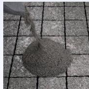
2. Vakuumbbeutel aufschneiden und frisches Material auf die nasse Belagsoberfläche schütten.
