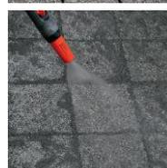
4. Bei Fugen von 3 - 8 mm das Einbringen in die Fugen mit dem Wasserstrahl unterstützen. Bei besonders schmalen Fugen den Wasserstrahl entlang den Fugen führen. Nachgesackte Fugen sofort mit frischem Material auffüllen.
