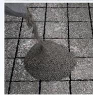
2. Vakuumbbeutel aufschneiden und frisches Material auf die nasse Belagsoberfläche schütten.
