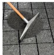
3. Prima Pflasterfugenmörtel 1K mit einem Gummischieber unter Druck in die Fugen einarbeiten.
