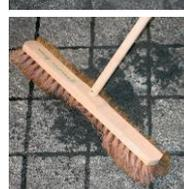
5. Mörtelreste mit einem weichen Besen vollständig von der Belagsoberfläche entfernen.
