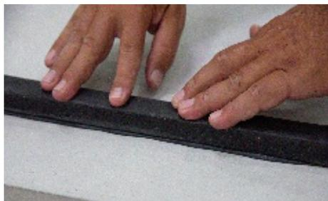
Das Quellband muss, beim Einlegen in die **Quellbandkleberraupe**, mit leichtem Druck hin und her bewegt werden um eine vollflächige und satte Verklebung gewährleisten zu können.
