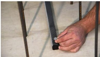
Das Quellbandgitter fest über das **MASTERSTOP Bentonitquellband** legen und mit Nägeln auf dem Beton befestigen. Das Nageln kann händisch oder mit einem Bolzensetzgerät erfolgen. Der Nagelabstand darf nicht größer als 20 cm sein.
