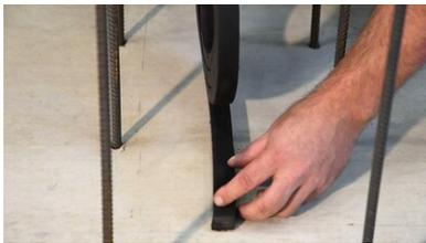
Nach dem Aufbringen des Quellbandklebers, wird das **MASTERSTOP Bentonitquellband** auf den Kleber aufgelegt und gleichmäßig angedrückt. Hierzu sollte das **MASTERSTOP Bentonitquellband** leicht hin und her, quer zur Längsachse, bewegt werden. Der Kleber sollte im Endzustand leicht an beiden Seiten herausquellen. Dies garantiert eine vollflächige Fixierung. Gebrauchsfest nach ca. 4 - 6 Stunden ( je nach Witterung )
