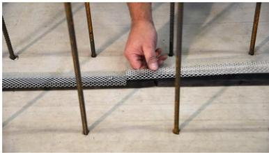
Bei Stumpfstößen in der Geraden und der Verwendung von Quellbandgittern sollten die Stöße von Quellband und Quellbandgitter versetzt ausgeführt werden.
