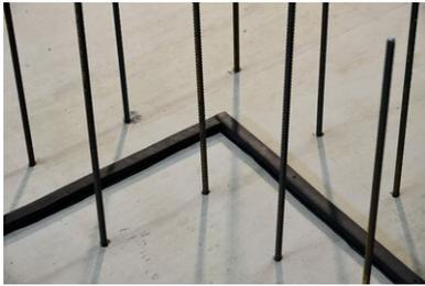
Stöße, egal ob bei Ecken oder Geraden, werden als Stumpfstoß ausgeführt. Die Stöße müssen formschlüssig sein um Fehlstellen im System zu vermeiden.
