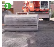
3 Verdichten mit Rüttelplatte
