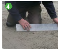
4 Egalisierungsschicht egalisieren
