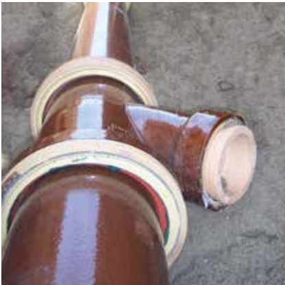
Einbaubeispiel: KeraBase Abzweig 45° – Normallast
