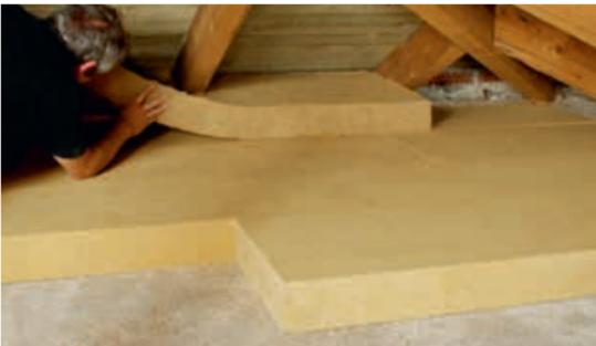
Der Zuschnitt kann mit allen gängigen Holzbearbeitungswerkzeugen erfolgen. So können schnell große Flächen gedämmt werden.
