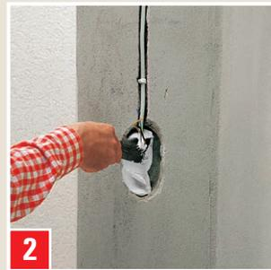
**Montage einer Steckdose:** Hohlraum mit ELEKTRIKERGIPS auffüllen.
