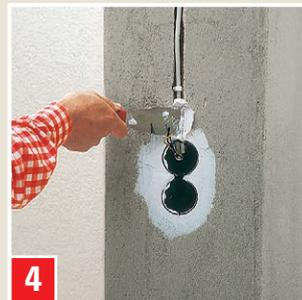
**Verlegen einer elektrischen Leitung:** Leitungsschlitz mit ELEKTRIKERGIPS schließen.
